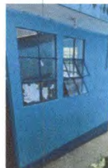
Foto 16: 5.6. Sustitución de balcones de metal
