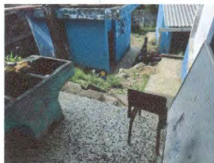
Foto 14: 11.2. Mantenimiento a barandas
