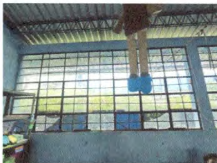
Foto 19: 5.6. Sustitución de balcones de metal
