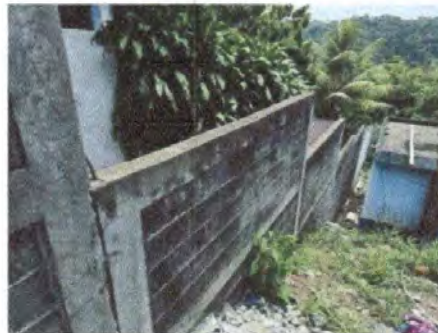
Foto 2: 9.1. Pintura en muros exteriores e interiores
