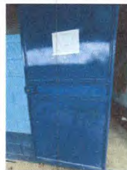
Foto 18: 4.1. Mantenimiento a estructura (aplicación de pintura)
