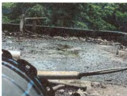
Foto 27: 3.2. Reparación de pañuelos
