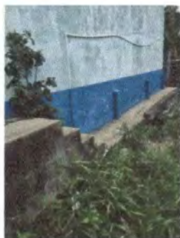
Foto 3: 14.9. Sustitución de tubería línea principal
