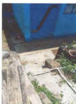
Foto 11: 6.5. Sustitución de piso de torta de concreto
