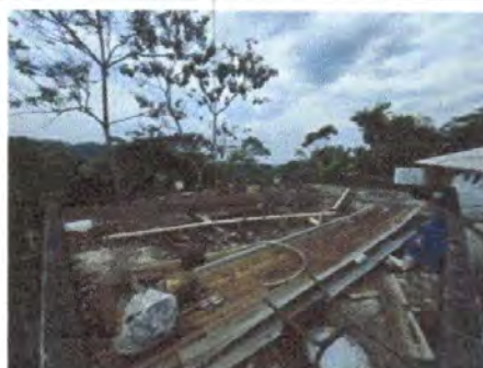
Foto 26: 3.1. Impermeabilización de losa
