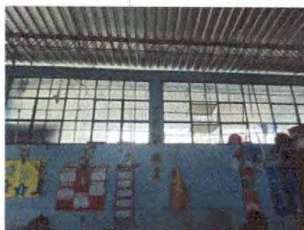
Foto 20: 5.6. Sustitución de balcones de metal
