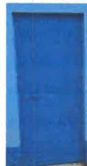
Foto 8: 4.1. Mantenimiento a estructura (aplicación de pintura)
