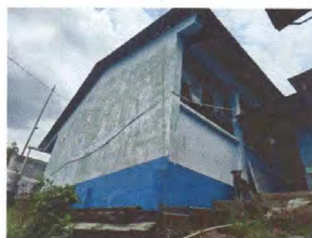
Foto 12: 9.1. Pintura en muros exteriores e interiores
