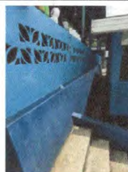
Foto 6: 9.1. Pintura en muros exteriores e interiores
