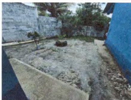
Foto 21: 6.5. Sustitución de piso de torta de concreto
