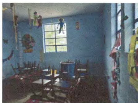
Foto 17: 9.1. Pintura en muros exteriores e interiores
