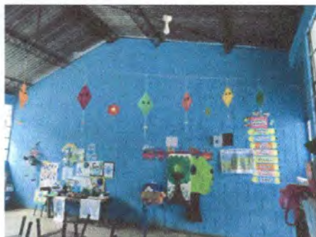
Foto 13: 9.1. Pintura en muros exteriores e interiores
