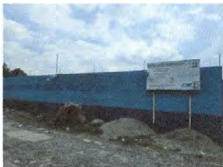
Foto 1: 9.1. Pintura en muros exteriores e interiores
