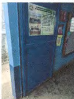
Foto 5: 4.1. Mantenimiento a estructura (aplicación de pintura)
