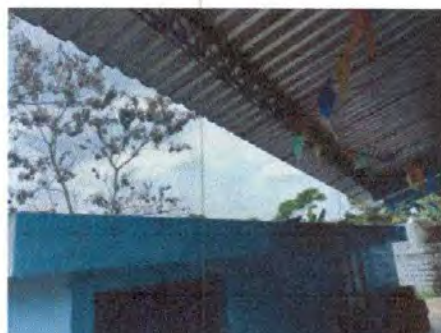
Foto 22: 7.2. Sustitución de canal de PVC
