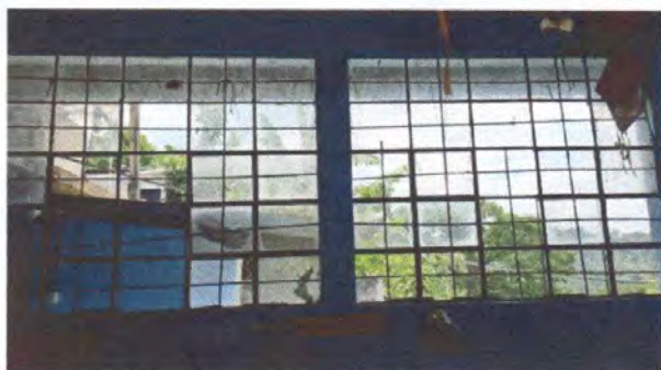
Foto 9: 5.6. Sustitución de balcones de metal
