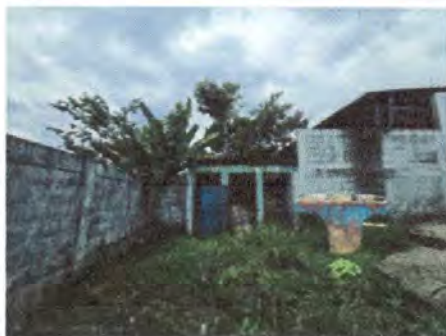
Foto 25: 20.10. Sustitución de pila de cemento de dos lavaderos
