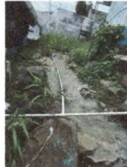
Foto 4: 14.9. Sustitución de tubería línea principal
