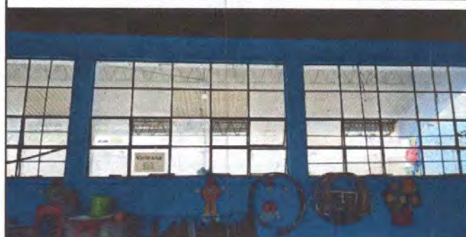
Foto 10: 5.6. Sustitución de balcones de metal
