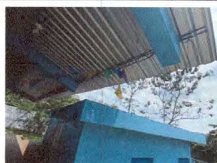
Foto 24: 7.5. Sustitución de soporte o pescante de metal para canal
